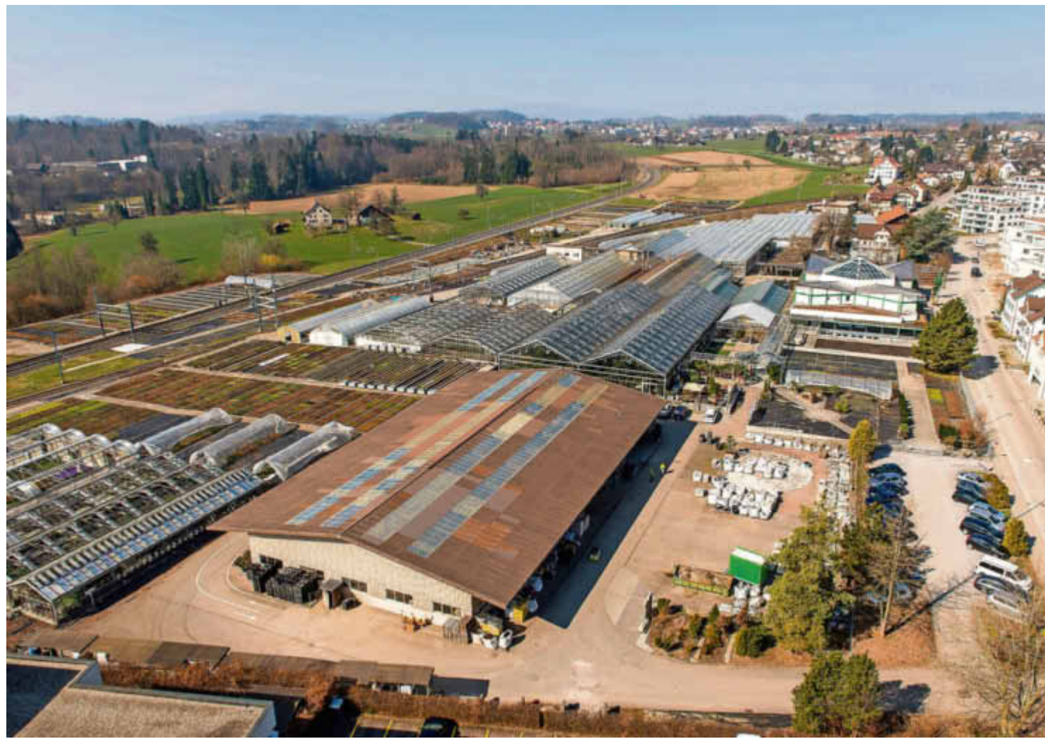
Am Standort in Tann plant das Garten-Center Meier, die Hallen und Gewächshäuser schrittweise zu modernisieren. Bild: Markus Zürcher
